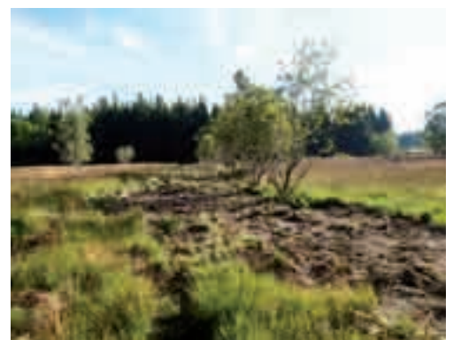
Rebouchage des anciens drains (2018).
